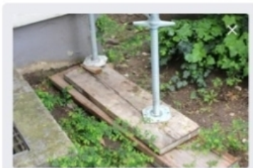
Kein Stand- und Tragsicherheitsnachweis hinterlegt. Aufstandsfläche sieht instabil aus.
